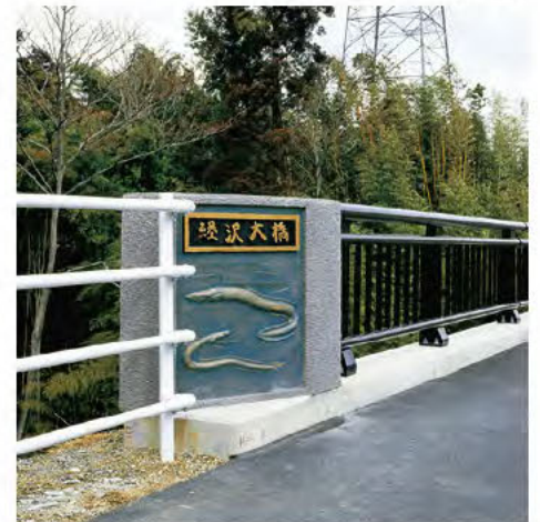
うなぎ沢大橋
