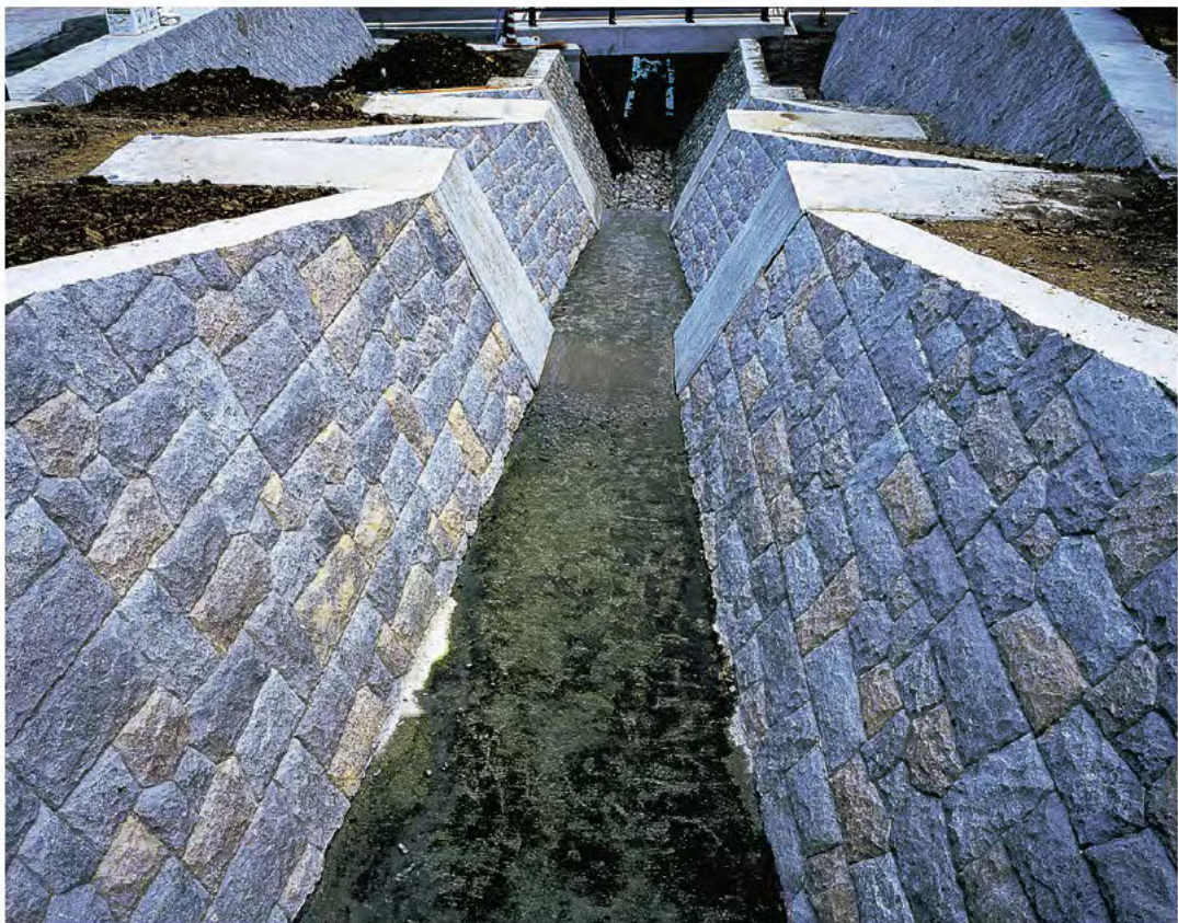
南沢川砂防ダム
